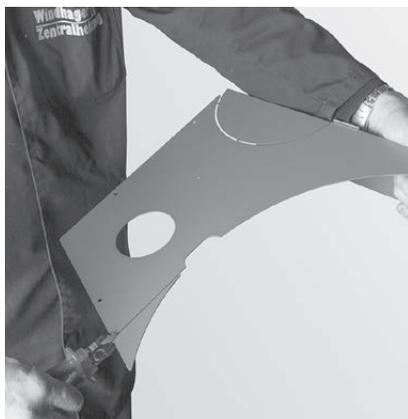
Fig. 77 Staccare con le tenaglie l'angolo del rivestimento sinistro superiore
