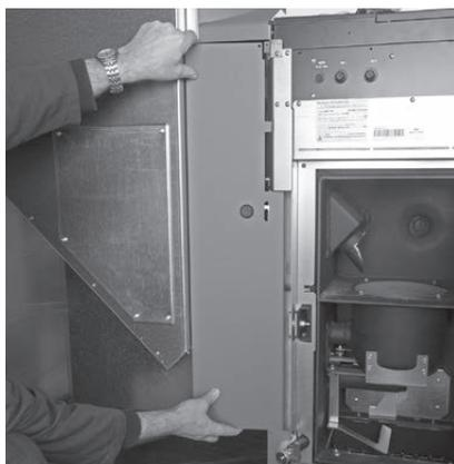
Fig. 81 Infilare il rivestimento anteriore
